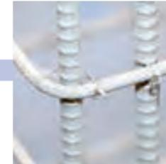
結束線という針金を使って鉄筋同士を固定します。
