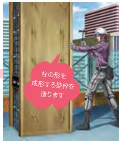
鉄筋の周囲にベニヤ板や角材を使って「**型枠**」を建込み、コンクリートを流し込めるようにします。
