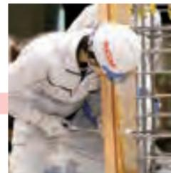
型枠部材（セバレータ）でさらに固定。ミリ単位でズレをなくすることが大切!
