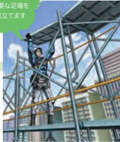
建物を1階から2階、3階へと上に造っていくために、足場（作業スペース）を組みます。この足場を使って鉄筋や型枠作業などが行われます。
