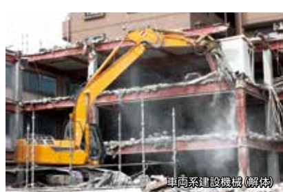
車両系建設機械(解体)
