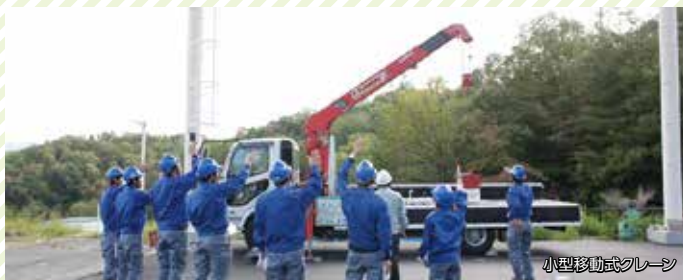
小型移動式クレーン
