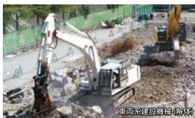
車両系建設機械(解体)
