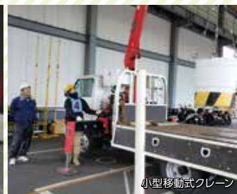
小型移動式クレーン
