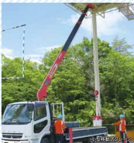
小型移動式クレーン
