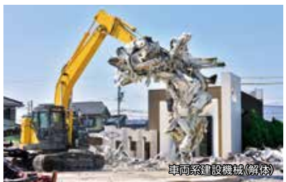
車両系建設機械(解体)
