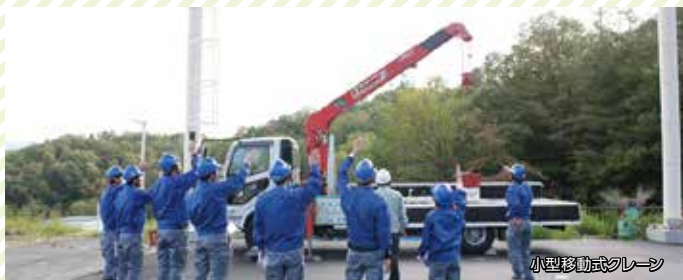
小型移動式クレーン
