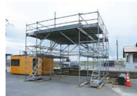
足場の組立て 実技場 足場の組立て作業を安全に行うための責任者を育成。
