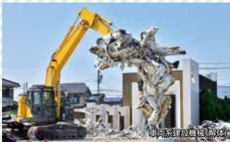
車両系建設機械(解体)
