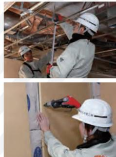
鉄筋コンクリートの室内空間に壁や天井などの間取り（区画）やクロス貼りなどの下地を作る仕事です。近年、耐火壁や、耐震天井など、地震災害対策でも注目を浴びています。
