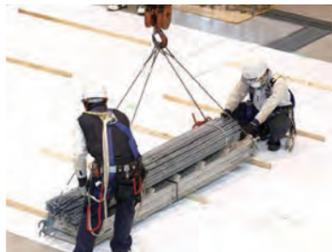
建設現場で主に資機材の積み下ろしなどの作業を行う際、資機材やクレーンフックなどにワイヤーロープなどを掛けたり外したりする作業があります。これが玉掛けです。建設現場で働くうえで必要不可欠な資格として、取得後は建設現場で広く活躍できます。すべての玉掛け作業に従事できます。
