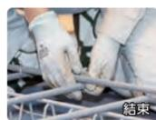
国家資格の「鉄筋施工技能検定」で行われる実技試験をもとにした教材。鉄筋を組立てる結束(けっそく)を体験する
