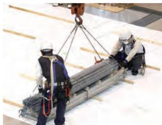
建設現場で主に資機材の積み下ろしなどの作業を行う際、資機材やクレーンフックなどにワイヤーロープなどを掛けたり外したりする作業があります。これが玉掛けです。建設現場で働くうえで必要不可欠な資格として、取得後は建設現場で広く活躍できます。すべての玉掛け作業に従事できます。
