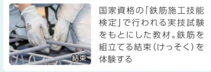
国家資格の「鉄筋施工技能検定」で行われる実技試験をもとにした教材。鉄筋を組立てる結束(けっそく)を体験する
